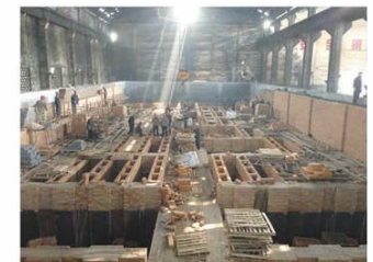
施工现场 Construction Site
